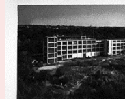
Egon-Eiermannbau Hardware: - flexible / temporäre Büro/Einzelheiten
